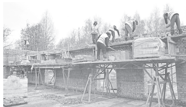
Строительство многофункционального центра в д. Пестрецово
